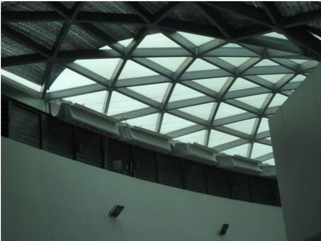
公共服务大厅顶棚遮阳
