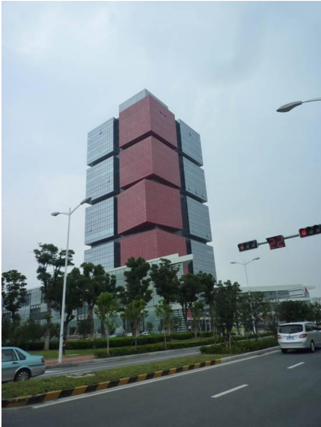
主楼采用大面积的彩釉玻璃等较为有效的减缓玻璃幕墙产生反射光影响的措施
